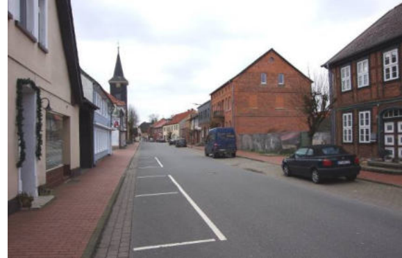
Im Verlauf der Hauptstraße in Brome muss die B 249 auch Flächen für den ruhenden Verkehr aufnehmen.
