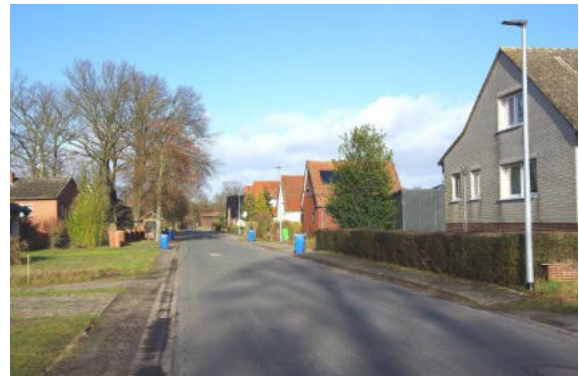
In Kaiserwinkel kann der schmale Schotterstreifen für Fußgänger an der Ortsdurchfahrt der K 87 keine Verkehrssicherheit bieten.
