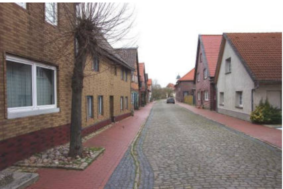
In der Straße Junkerende konnte die historische Pflasterung gewahrt werden.
