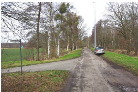
Der Försterkampsweg im Nordosten von Kaiserwinkel bedarf einer Erneuerung.
