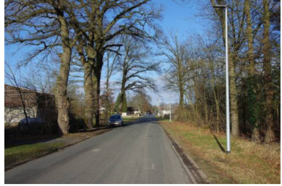
Die Ortsdurchfahrt der K 85 wird teilweise als Abkürzung genutzt; durch den unzureichenden Gehwegstreifen ergeben sich dabei Gefahrenmomente für Fußgänger.
