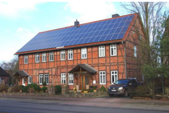
Photovoltaik-Anlagen werden bei einer Dacherneuerung im Rahmen der Dorfentwicklung nicht gefördert; sie werden aber – bei gewissem Abstand zu den Dachrändern – geduldet.
