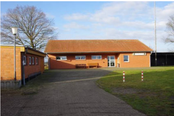
Das Sportheim – der Bedarf für eine Erweiterung könnte auf den alten Tennisplätzen gewährleistet werden.
