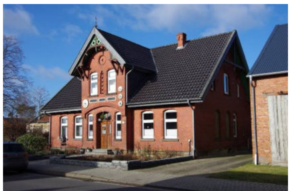
Die Ausstattung einer Wärmedämmung im Dach sollte nicht auf den Sparren erfolgen; durch können die Proportionen des Gebäudes gestört werden.
