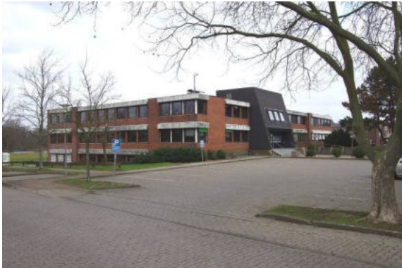
Das Rathaus mit dem vorgelagerten Parkplatz stellt sich als Zweckbau dar.
