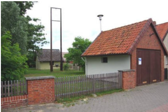
Das alte Spritzenhaus und das rückwärtig gelegene Gemeinschaftshaus bilden das gemeinschaftliche Zentrum; hier besteht Erneuerungsbedarf.
