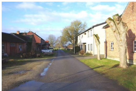
Der Erneuerungsbedarf der Straße Moortrift umfasst auch die Ableitung des Oberflächenwassers.
