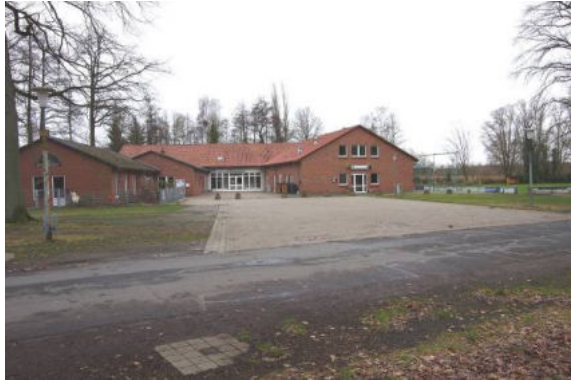
Das Bürgerzentrum bildet zusammen mit der Gaststätte und dem Kindergarten einen zusammenhängenden Gebäudekomplex.
