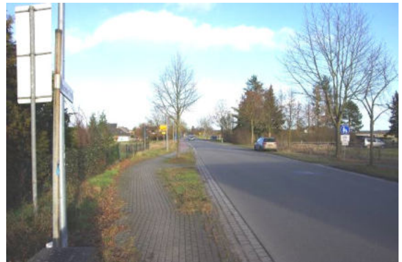
In der nördlichen Ortseinfahrt verleitet der geradlinige Straßenverlauf zu überhöhten Geschwindigkeiten.
