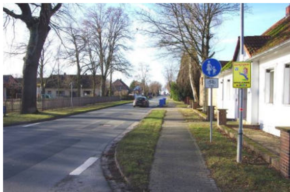
Auf der Ortsdurchfahrt der L 287 in Zicherie werden oft überhöhte Geschwindigkeiten gefahren, was ein Gefährdungspotential darstellt.
