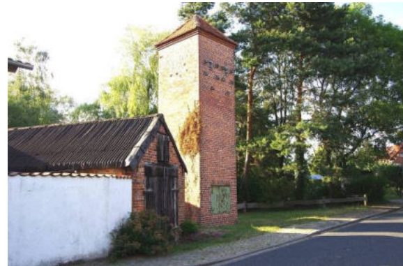
Nahe am Dorfteich bilden der ehemalige Trafoturm und das frühere Spritzenhaus ein markantes Ensemble.
