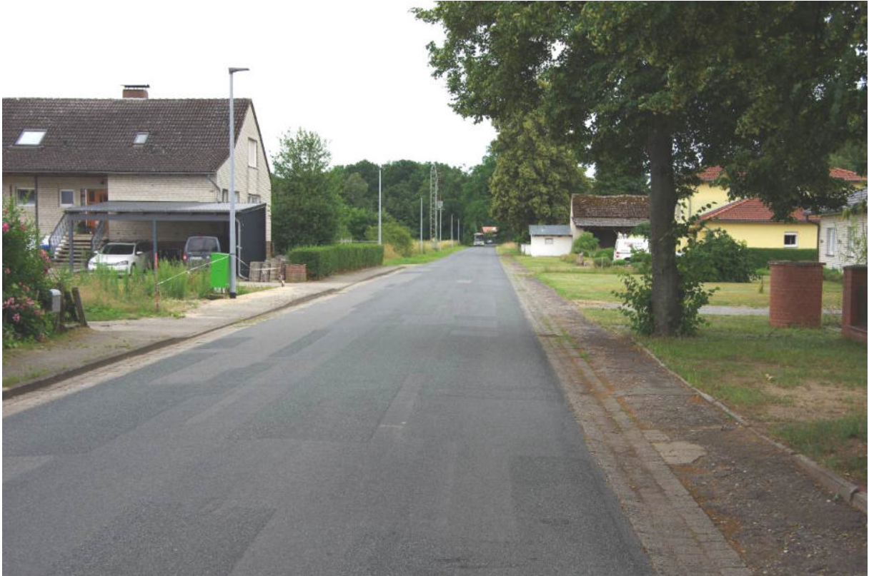
Der schmale Gehwegstreifen an der Ortsdurchfahrt ist baulich schadhaft und kaum noch erkennbar, so dass die Fußgänger die Fahrbahn nutzen (müssen).
