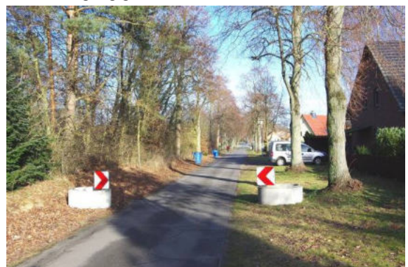
Neben den Wurzelschäden ist die Straße Alter Schulweg durch Abkürzungsverkehr beeinträchtigt.
