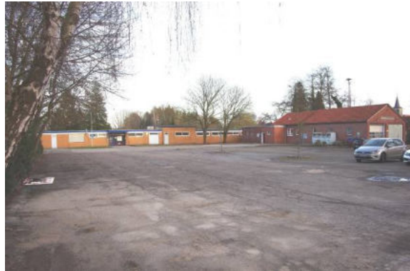
Das Freibad und der vorgelagerte zentrale Parkplatz des Ortes weisen einen umfassenden Erneuerungsbedarf auf.
