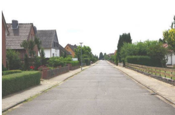
In den ausgedehnten jüngeren Siedlungsbereichen weisen die Straßenräume vielfach Erneuerungsbedarf auf; allerdings kann sich hier keine Förderung mit der Dorfentwicklung ergeben.
