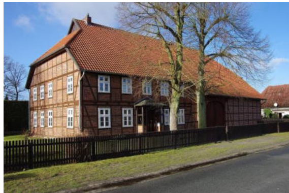
Das quererschlossene Wohnwirtschaftsgebäude in Lessien ist weitgehend bauzeitlich überliefert.
