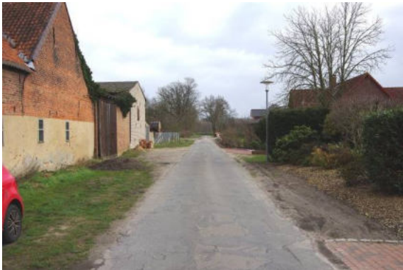
In Brome ist der Klötzer Weg abgängig, dem neben der Erschließung eines landwirtschaftlichen Betriebes auch als Zuwegung zur Burg Bedeutung beikommt.
