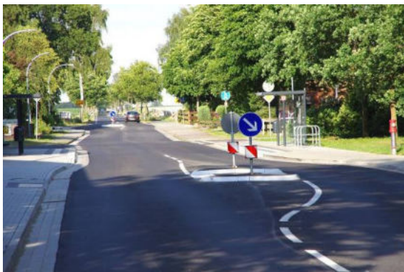
Die Ortsdurchfahrt im Zuge der B 248 wurde vor wenigen Jahren neu ausgebaut. Drei Fahrbahnteiler bzw. Querungshilfen sorgen für eine gezielte Gliederung.
