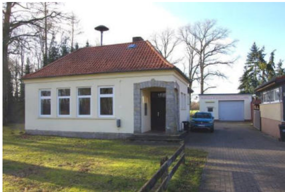
Die als Gemeinschaftshaus genutzte ehem. Schule weist umfassenden Modernisierungsbedarf auf.
