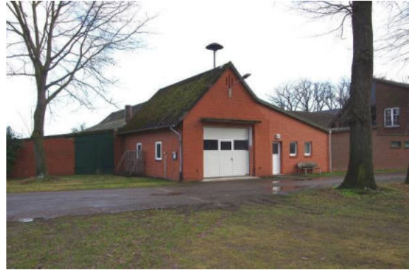
Aufgrund seiner geringen Größe muss das Feuerwehrhaus an der Straße Am Teich langfristig ersetzt werden.
