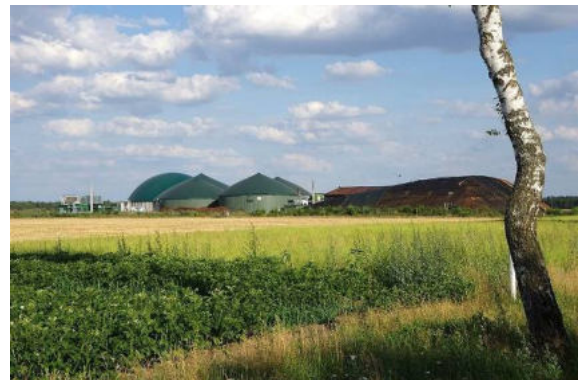
In Brome, Parsau und Tülow werden Biogasanlagen betrieben, die zur Energiewende beitragen.
