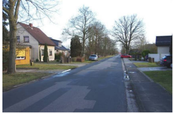
Die Nebenanlagen der Alte Bahnhofstraße (K 91) weisen Erneuerungsbedarf auf.
