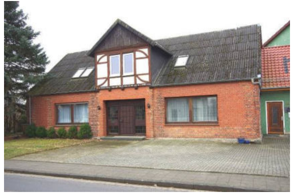
Trotz erheblicher Veränderungen ist das Altgebäude noch erkennbar – und wäre damit förderfähig.
