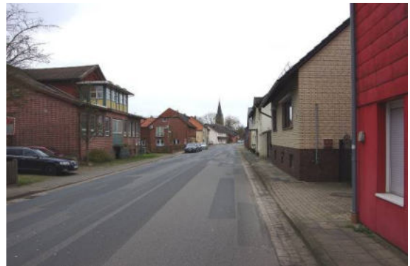
Die für 2023 geplante Erneuerung der Ortsdurchfahrt der B 244 in Parsau bietet die Chance für eine dörflich angepasste Neugestaltung.
