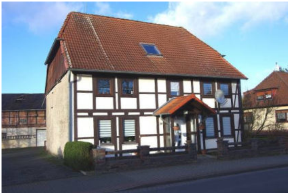
Verändertes Gebäude in Ahnebeck – Gebäudeform und Fachwerkstruktur sind aber erhalten.
