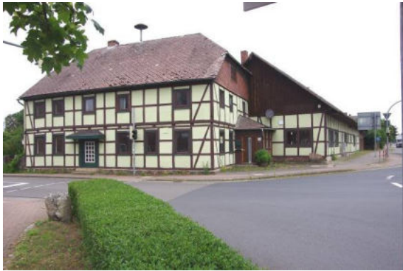
Aufgrund seiner Lage, einer Größe und der weitgehend erhaltenen Gebäudestruktur erweist sich dieses Gebäude in Ehra als ortsbildprägend.
