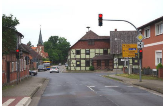
Wenn später die A 39 ausgebaut und der Verlauf der B 248 aus der Ortslage von Ehra verlagert wird, können Bereiche der heutigen Ortsdurchfahrt deutlich zurückgebaut werden.
